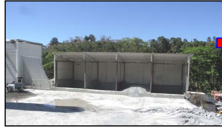
Racks de remplissage des trémies de granulats
